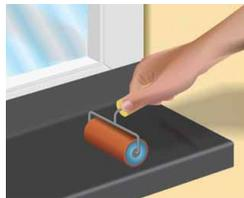
Mit Hilfe eines Kunststoffrollers die SikaMembran®-Folie andrücken. Es ist darauf zu achten, dass die Folie auf der Breite von 4 cm vollflächig verklebt ist.
