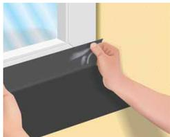
SikaMembran®-Folie schleifenförmig ankleben. Folie in den Klebstoff eindrücken. Bei Folienüberlappung mindestens 10 cm Überlappungslänge einhalten.
