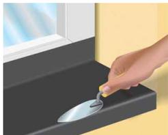
Anschließend die Folienkante mit einem Spachtel in den überschüssigen Klebstoff drücken. Bis 30 Minuten nach der Verklebung besteht die Möglichkeit, die verklebten Folien nachzjustieren.
