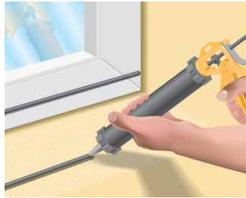
Klebstoff SikaBond®-TF plus N mittels Schlauchbeutepistole und Düse auftragen (Düsendurchmesser ca. 8 mm)
