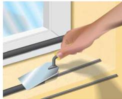
Mit einem Spachtel die Klebstoffraupe am Bauwerk auf ca. 4-5 cm Breite und 1 mm Dicke (je nach Untergrund) verziehen, am Fensterelement genügt eine Breite von 2-3 cm und eine Dicke von 1 mm.
